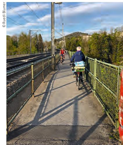
Der Steg an der SBB-Brücke über die Sitter wird endlich verbreitert.
